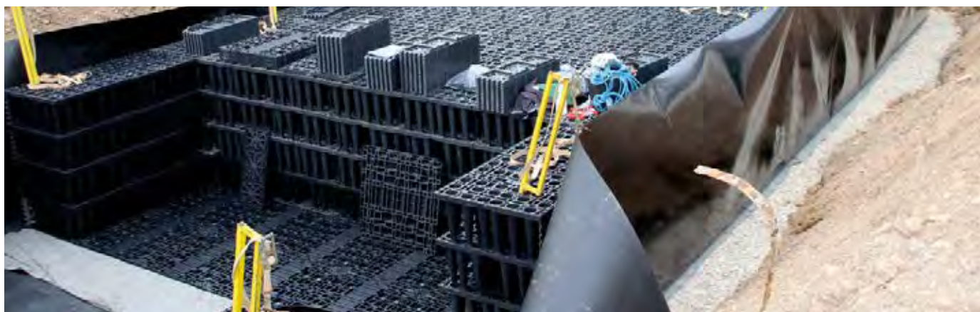
Die Module wurden bei der Montage zu einem Blockverbund zusammengefügt
